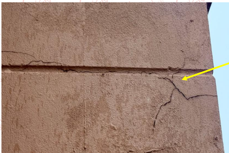
Al presentarse lluvias el agua ingresa por las diferentes fisuras presentes en el muro
