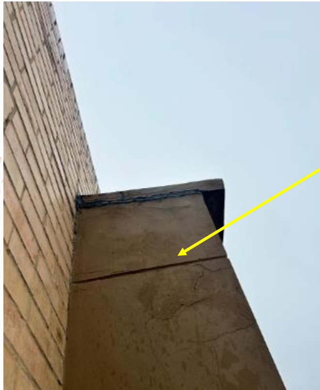
Fisura en dilatación muro complementario de fachada para ducha de baño
